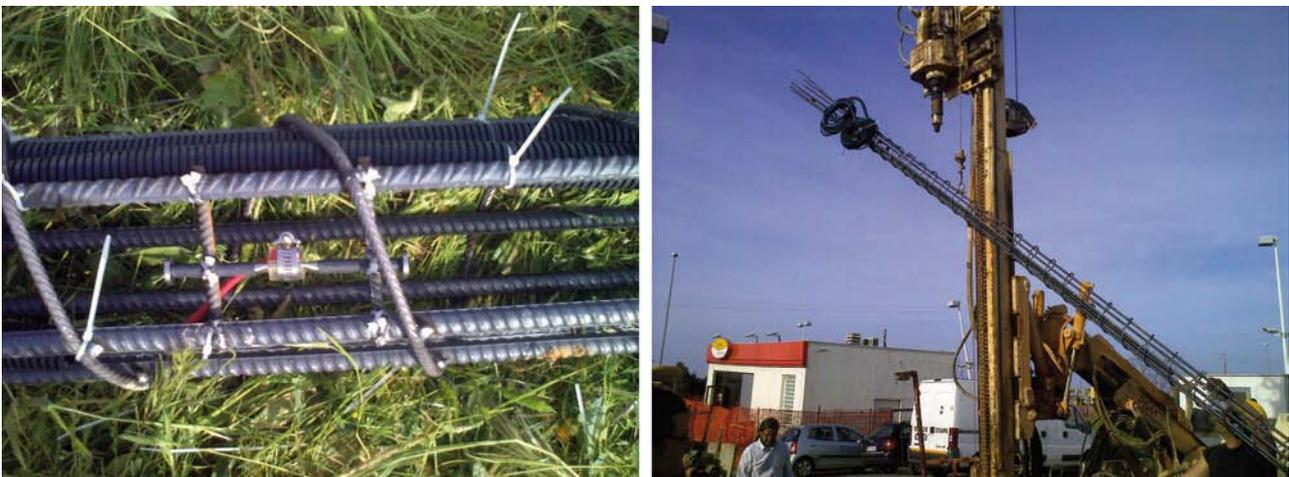
*Fig. 3 – Particolari dell'installazione dei sensori a corda vibrante*
